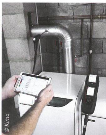
*Avec le Kigaz, de Kimo, l'analyse de combustion (gaz, pression et température) pour le contrôle et le réglage des émissions polluantes n'a jamais été aussi simple. Et bien sûr, les modèles restent évolutifs pour suivre les réglementations NOx à venir. Chaque analyseur est en plus livré avec un certificat d'étalonnage, une coque de protection en élastomère et une sacoche de transport. Ils sont complets, sans qu'aucune option soit nécessaire.*
