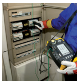
Maintenance tertiaire & industrielle, diagnostics & contrôles
